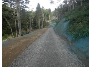
国有林での林道新設工事
