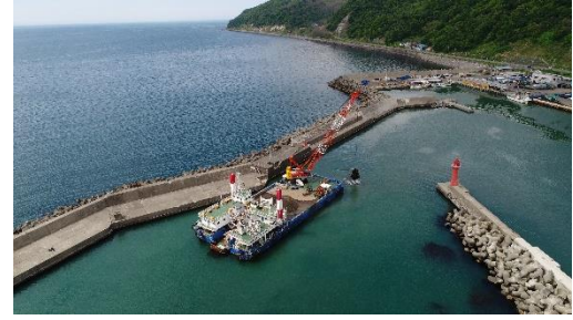
漁港内のしゅんせつ工事
