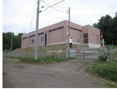
浄水場の建替え
