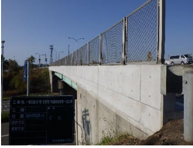
橋梁補修の工事
