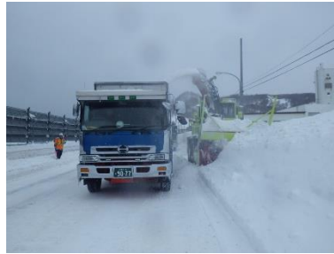
国道 231 号の運搬除雪
