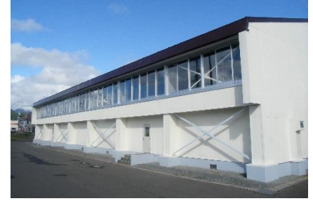
小学校の耐震補強改修
